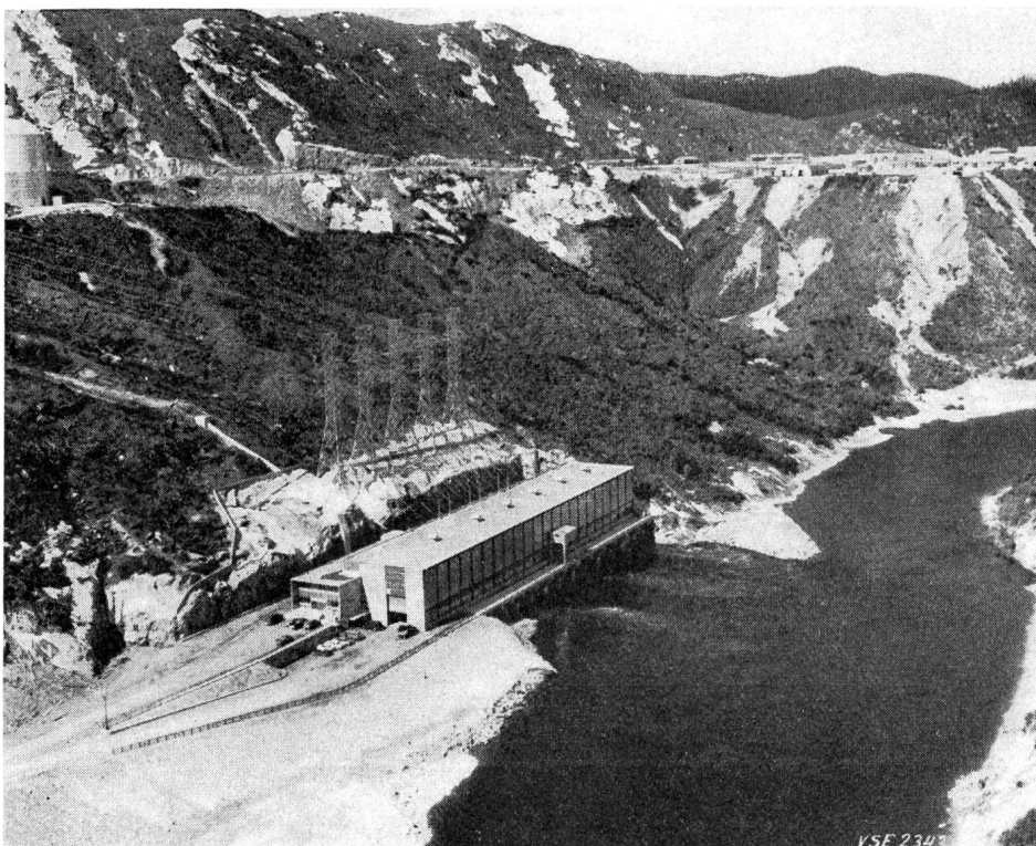
Fig. 9 Luftaufnahme der Zentrale Bersimis II
