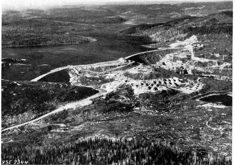
Fig. 8 Ansicht der Sperre des Cassé-Sees der Zentrale Bersimis
