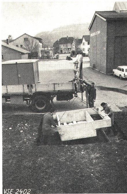
Fig. 9 Sprecher & Schuh-Station Einbringen der Fundament-Konstruktion
