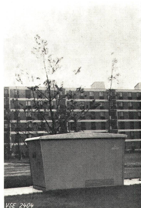
Fig. 11 Kompakt-Transformatorstation 400 kVA, Reihe 20 kV
