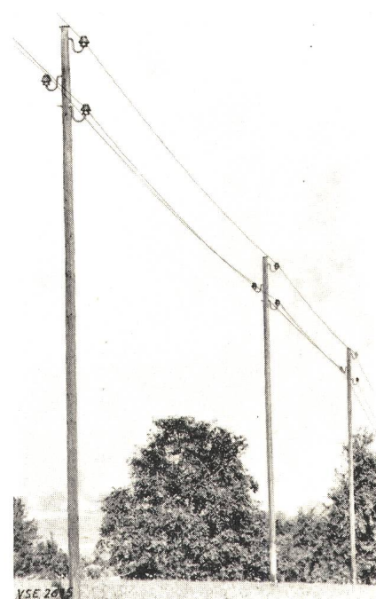
20 kV-Regelleitung (max. Spannweite 50 m) 1-strängig; auf Holzstangen
