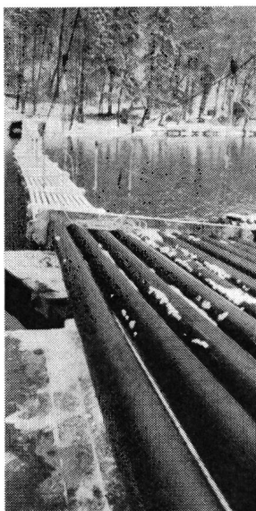
Verlegung von Kabel- schutzrohren in die Arve/Genf
