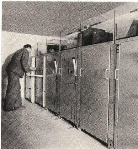
Unser standardisiertes Geräteprogramm kann leicht in die Zellen eingesetzt werden. Ölstrahlschalter, Lasttrenner und Messapparate auf Wagen bilden ein einheitliches, ausfahrbares Trennwagensystem. Die fest in den Zellen eingebauten Apparate bleiben gut zugänglich. Mit den modernen Kabelendverschlüssen kann heute jedes beliebige Kabel eingeführt werden. Verkürzte Montagezeiten werden durch anschlussfertige Bauteile nach dem Baukastensystem erreicht.
