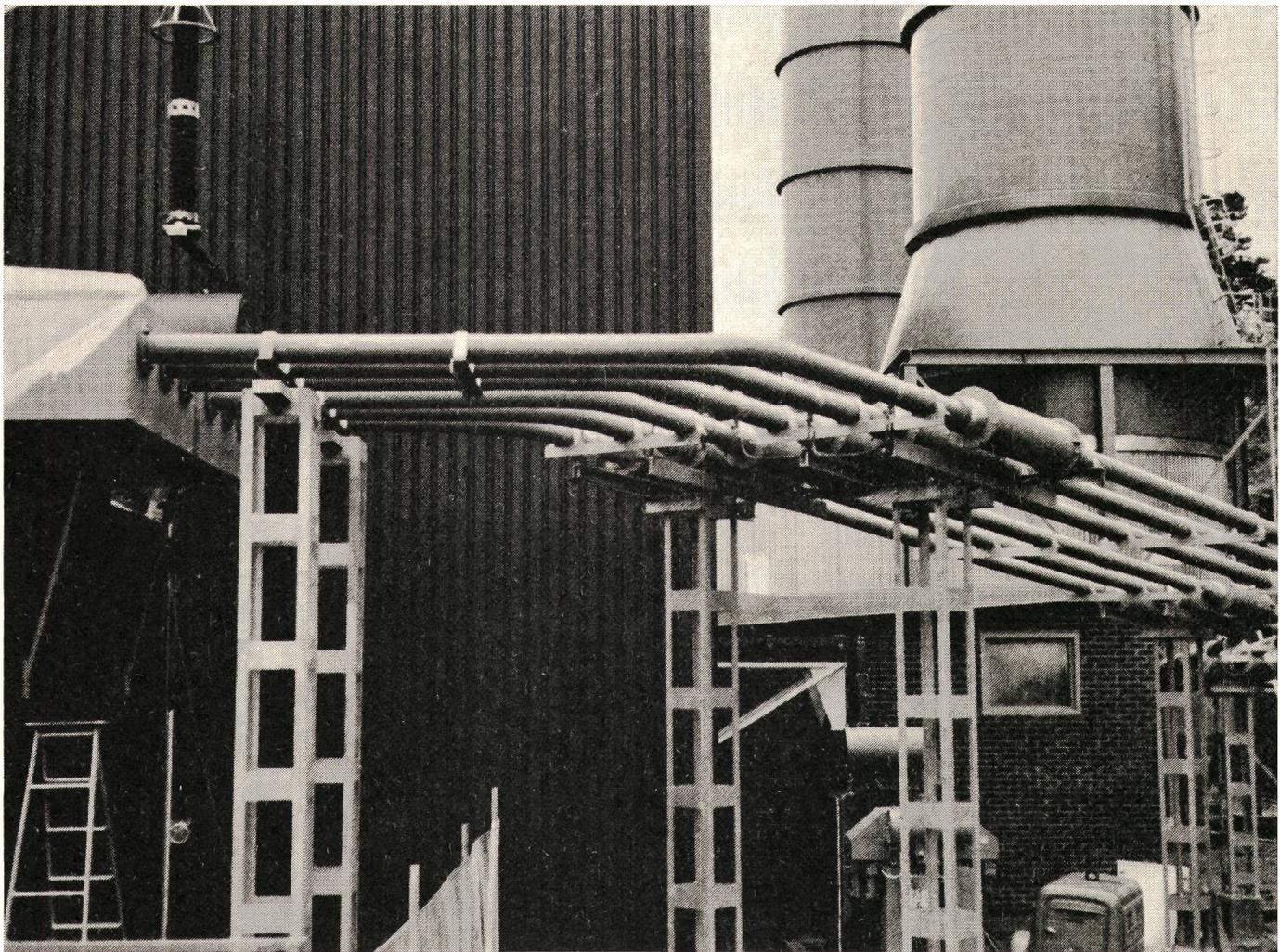
**Vollisolierte Generatorausleitungen 17,5 kV 4,8 kA
