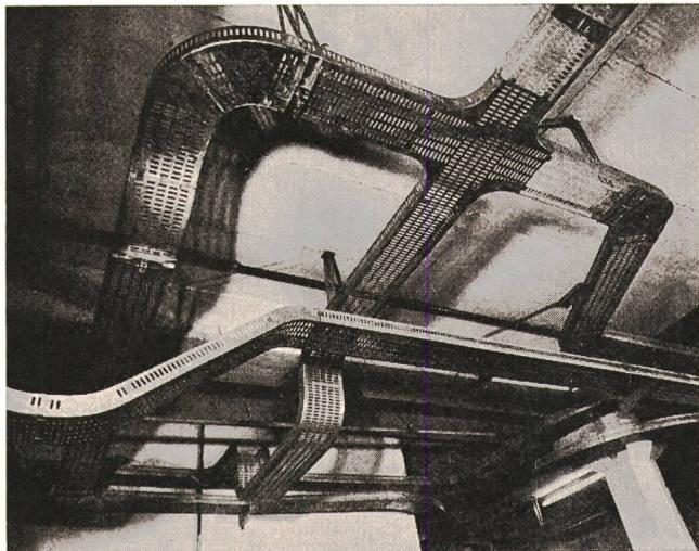
Neuartige, verstellbare, zentrale Decken-Aufhängung. Kein Einfädeln mehr. Die Kabel werden gestreckt eingelegt, da keine seitlichen, störenden Aufhängungen. Keine Spezialwerkzeuge nötig. Stark verkürzte Montagezeiten auch mit angelegtem Personal.
