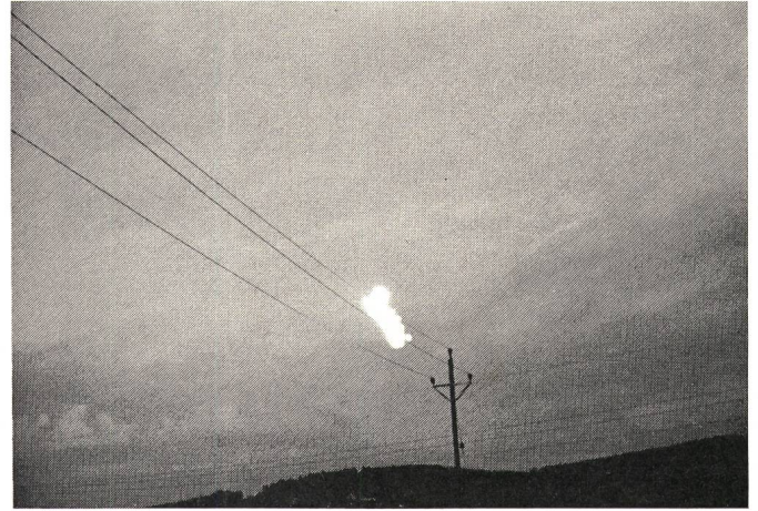
Fig. 7 Galvanischer Kurzschluss bei einem «scharfen» Wurf-Prüferdungs-Versuch auf einer 25-kV-Leitung, wie ihn das menschliche Auge (im Gegensatz zur Schnellbildkamera) wahrnimmt. (Aufnahme mit geringer Vorbelichtung)
