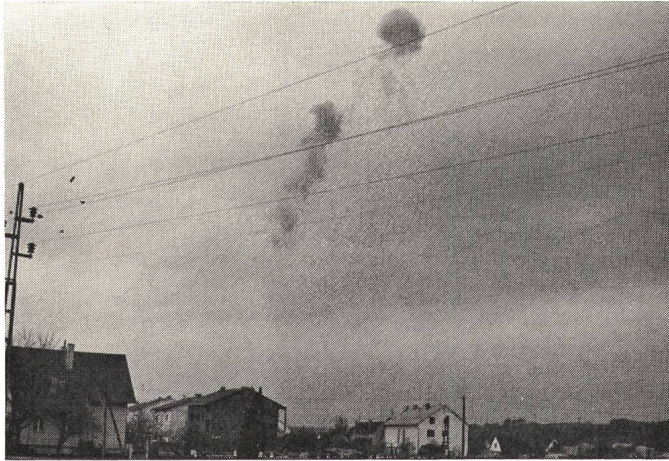
Fig. 6 Typischer Funkenregen, herrührend von Werkstoffabtragungen an den Kupfer-Leiterseilen im Wege eines bewusst bei einer Wurf-Prüferdung herbeigeführten Kurzschlusses auf einer 45-kV-Leitung.
