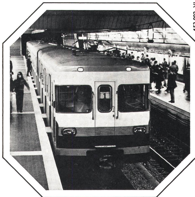
U-Bahn Barcelona: Triebwagen hoher Leistung mit vollelektronischer Fahrtregelung.
