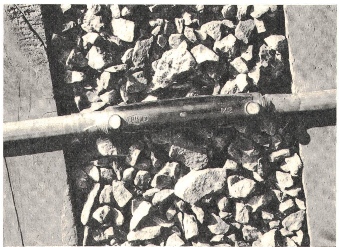
Fig. 8 Mit Polyolefinband umwickelter Verbindungskabelmantel
