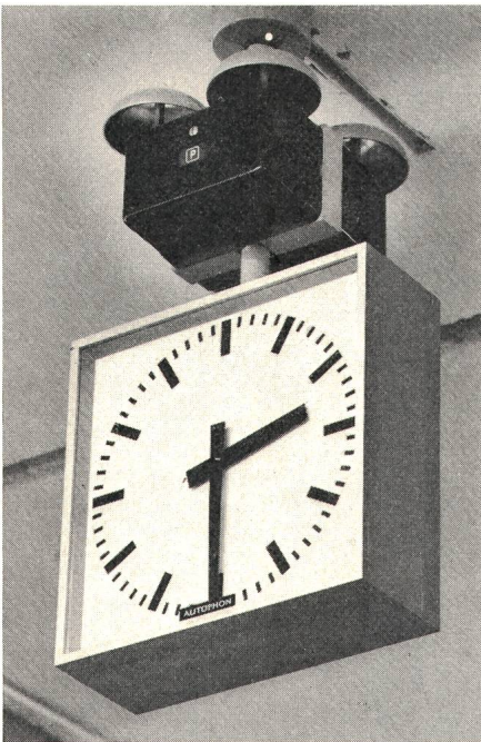
Fig. 10 Doppelnebuhr und Arbeitszeitsignal an Deckenpendel
