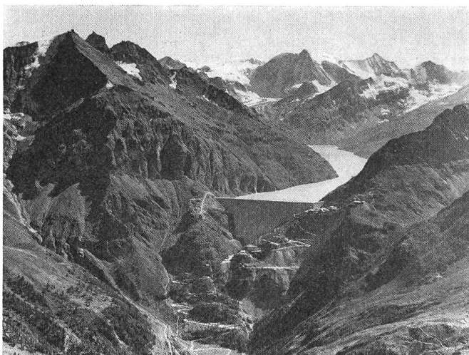
Fig. 1 Le barrage de Grande Dixence en Valais (hauteur 284 m, retenu: 400 millions de m 3 )
