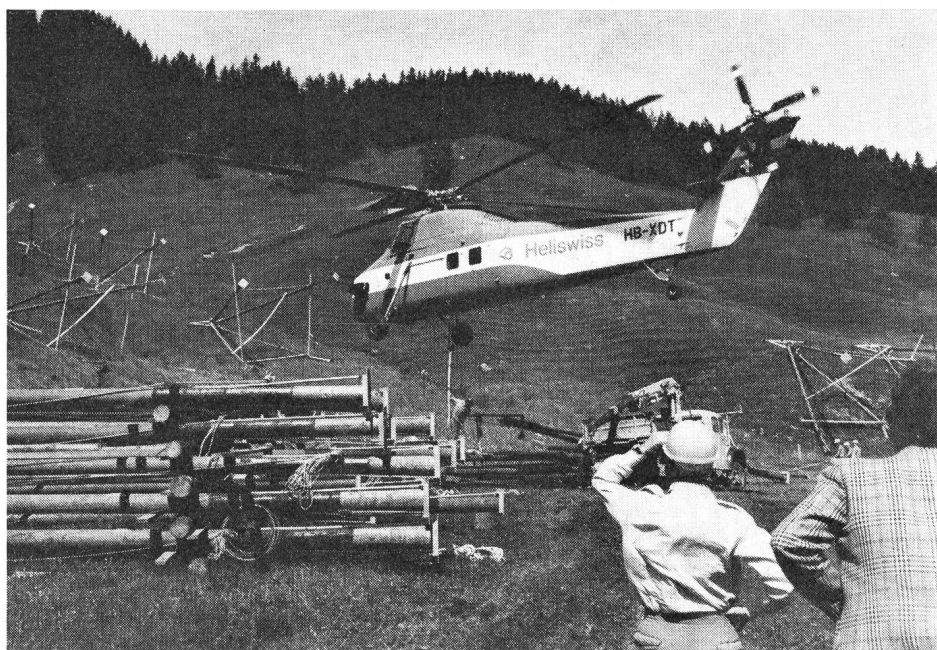
Fig. 6 Construction d'une ligne moyenne tension 17 kV en zone de montagne (Schweinsberg en Singine)
