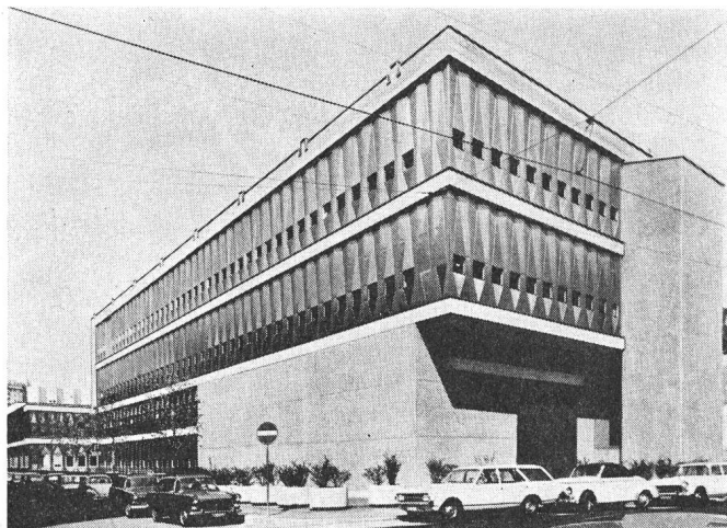
Fig. 5 Sous-station transformatrice 130/18 kV du Stand
