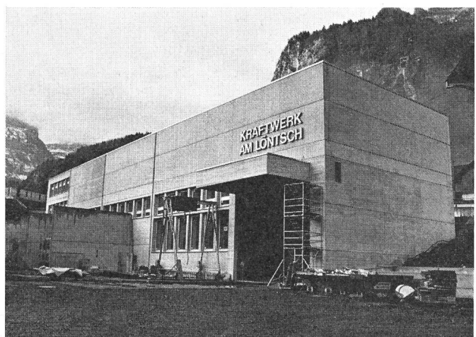
Umbau des Kraftwerkes Löntsch der NOK (Die Inbetriebnahme erfolgt am 15. Juni 1975)
