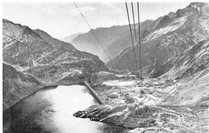
Fig. 7 Staudamm und Bassin von Robieci
