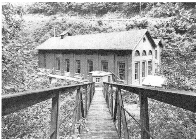
Fig. 1 Vue externe de la centrale de Morobbia, bâtie en 1900 à 1902
