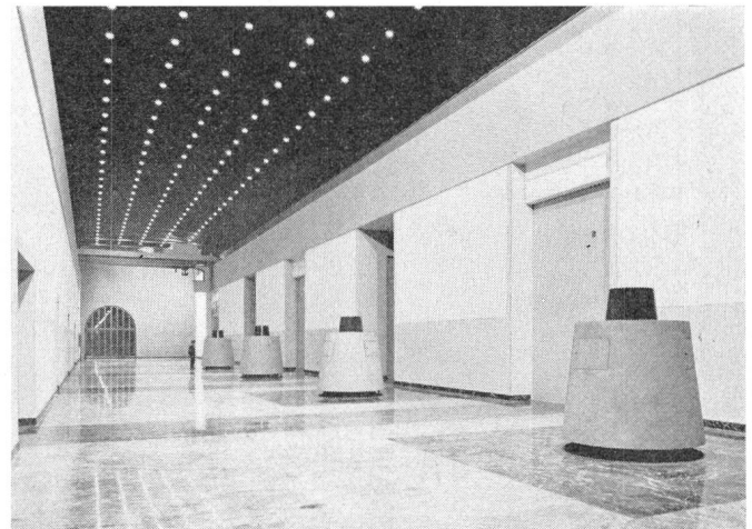
Fig. 8 Maschinensaal der Kraftwerkzentrale Robieci
