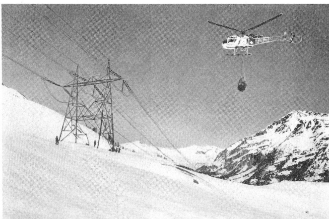
Fig. 3 Leitungsreparatur in den Alpen
