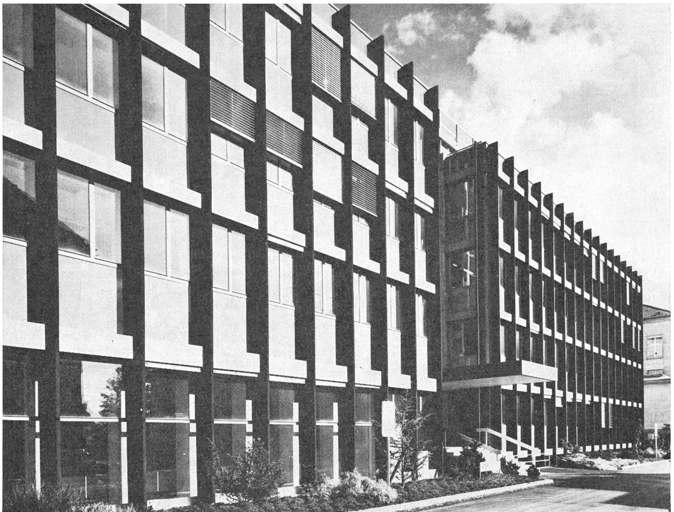
Fig. 1 Frontansicht des neuen Laborgebäudes Elektrotechnik der ETHZ
