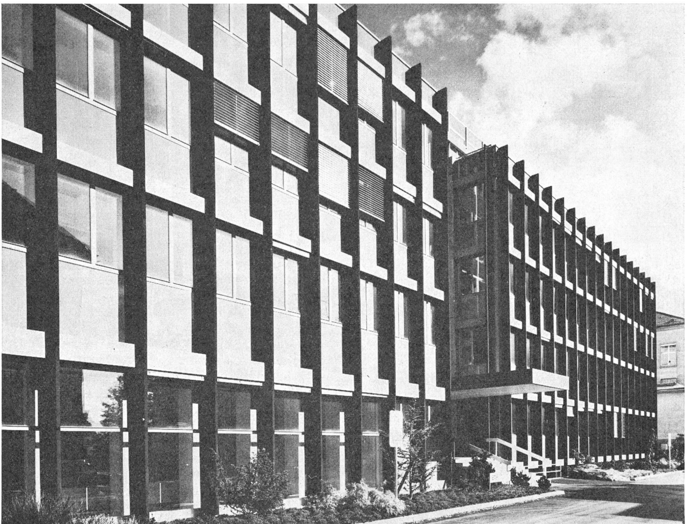
Fig. 1 Frontansicht des neuen Laborgebäudes Elektrotechnik der ETHZ
