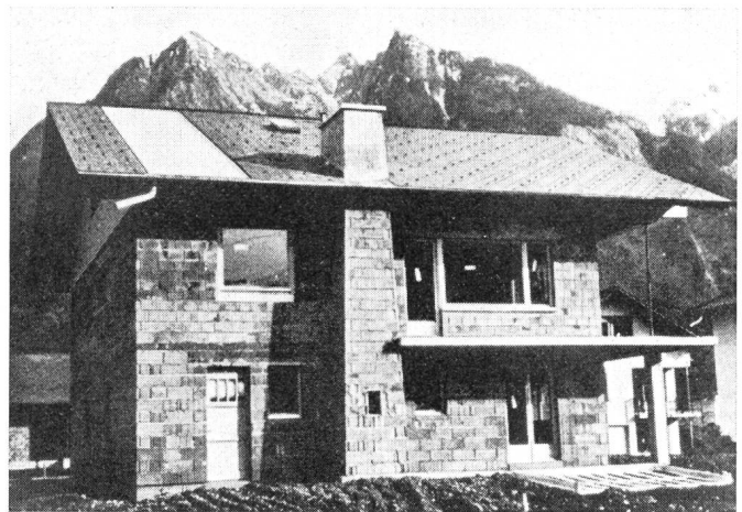
Fig. 5 Sonnenkollektor zur Erzeugung von Warmwasser, montiert auf dem Dach eines Wohnhauses Collecteur solaire pour la préparation d'eau chaude, monté sur le toit d'une maison d'habitation
