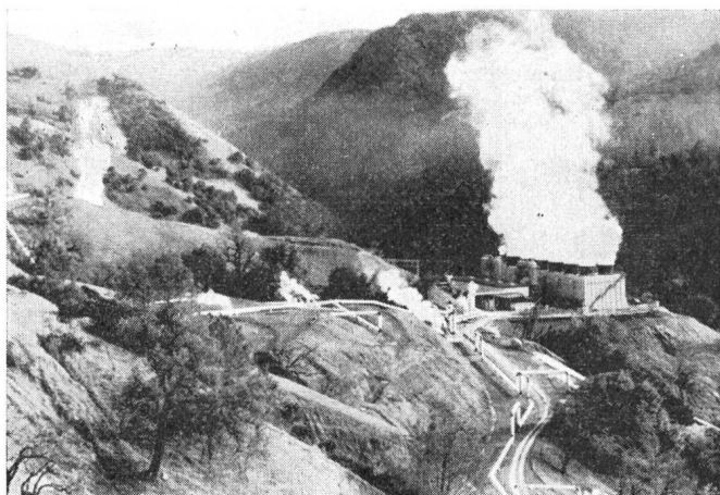
Fig. 2 Geothermisches Kraftwerk im Gebiet The Geysers, 140 km nördlich von San Francisco, Calif. Leistung in der Grössenordnung von 50 MW Centrale géothermique dans la région The Geysers, à 140 km au nord de San Francisco, Calif. Puissance de l'ordre de grandeur de 50 MW
