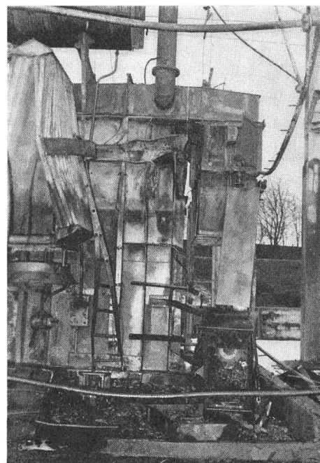
Fig. 5 Transformateur 30 MVA, 130/18 kV, détruit à l'explosif
