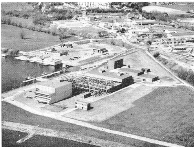
Fig. 6 Blick auf das Kurzschlusslaboratorium der KEMA, welches auch einen Transformatorenprüfstand enthält
