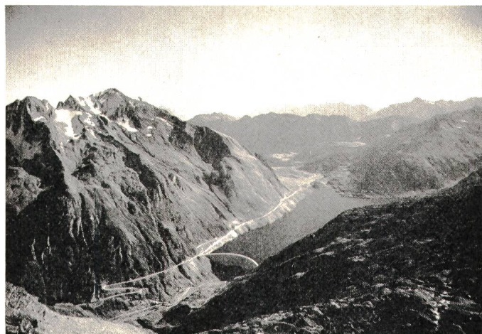
Fig. 3 Hochdruck-Speicherwerk Staumauer Sta. Maria am Lukmanier der Partnergesellschaft Kraftwerke Vorderrhein AG (KVR)
