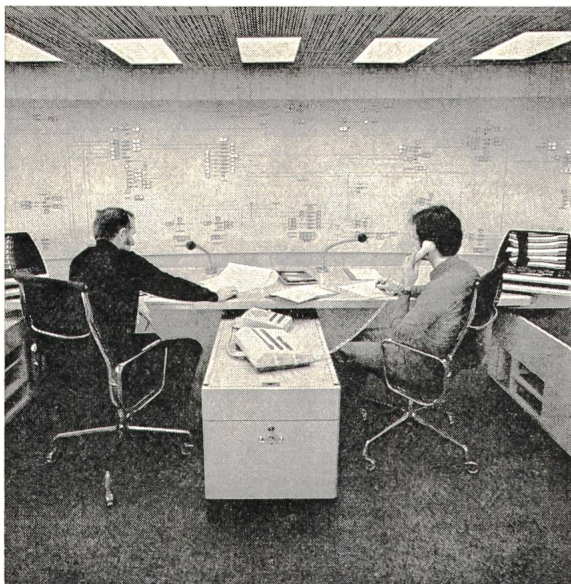
Fig. 4 Ansicht des Kommandoraumes mit Blindschalterschema
