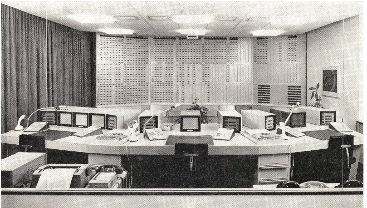
Fig. 7 Leitstelle der Verkehrsbetriebe der Stadt Zürich (VBZ)
