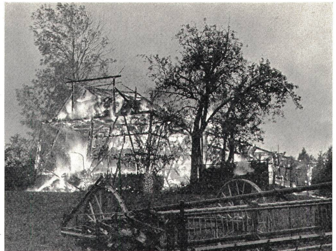
Fig. 6 Durch Blitzschlag verursachter Scheunenbrand
