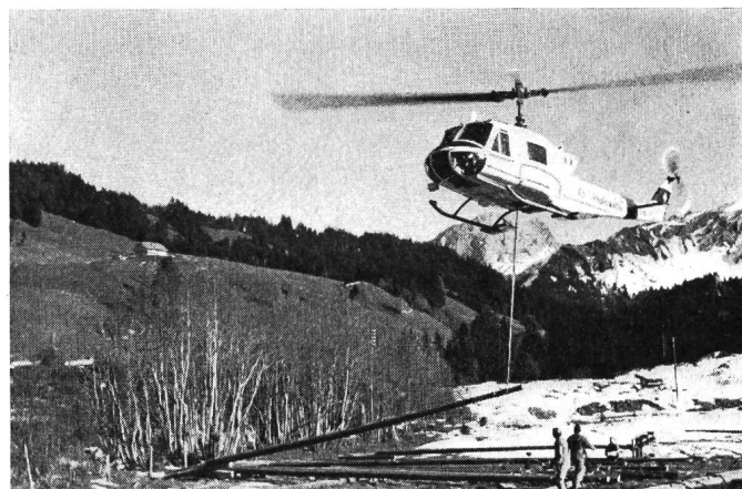
Fig. 1 Versorgungsgebiet der CKW im Entlebuch Einsatz des Helikopters beim Leitungsbau
