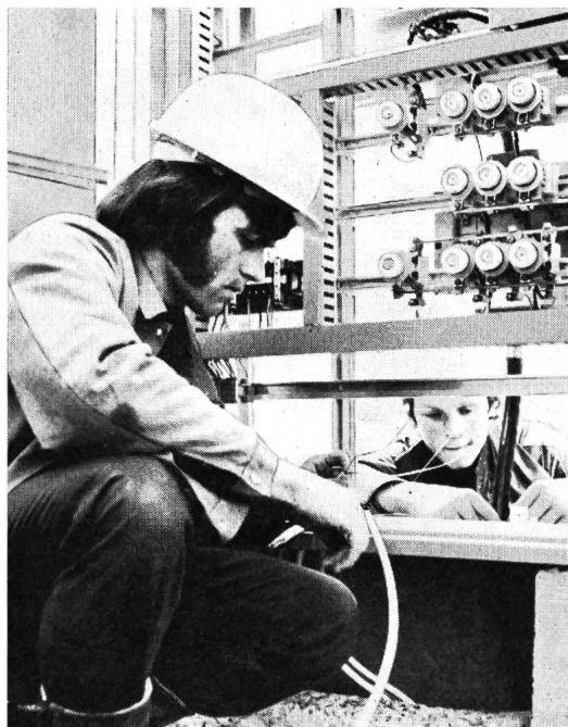
Fig. 3 Installationsmonteure beim Ausrüsten einer Hauptverteilung
