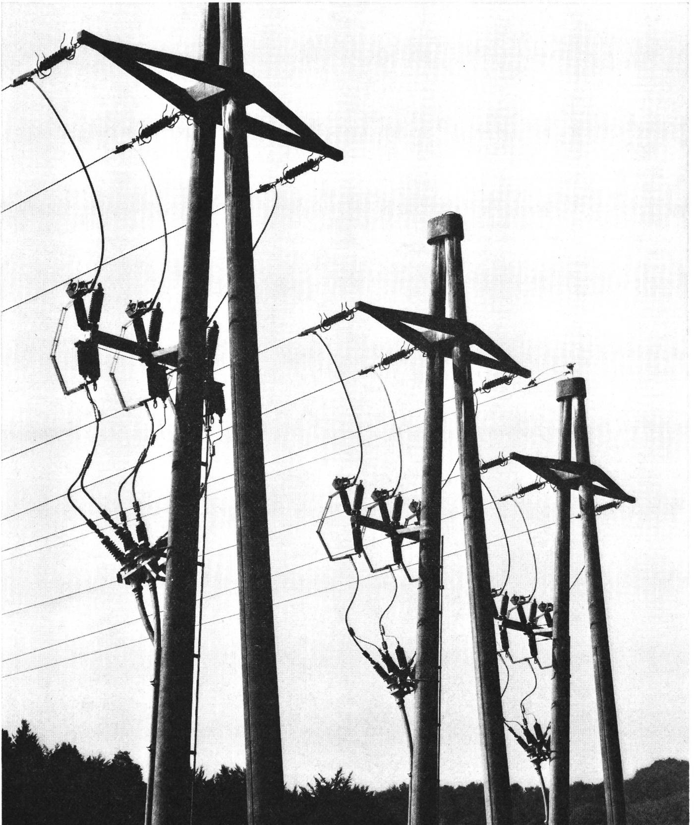
Energietransport ist ein komplexer Vorgang, vergleichbar einem Konzert: alles muss aufeinander abgestimmt sein und technisch fehlerfrei zusammenwirken. Unser Bild: Übergang von 20 kV-Dreileiter-Haftmassenkabeln auf 3 Freileitungen unter Verwendung von Dreileiter-Freiluft-Endverschlüssen auf Konsolen mit Überspannungsableitern.
