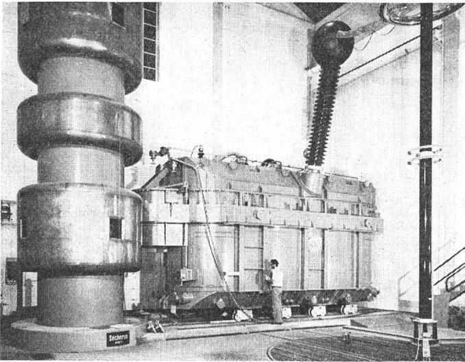
**Fig. 2 Drehstrom-Volltransformatoren-Bank**
