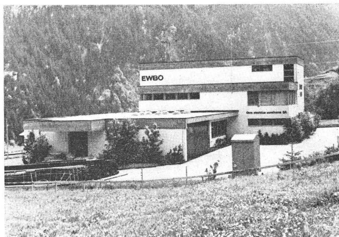
Fig. 1 Unterwerk 60/16 kV in Disentis mit Büro, Magazin und Werkstatt der Kreisbetriebsleitung in Disentis
