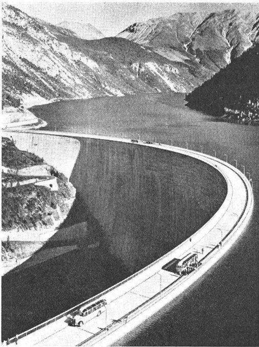
Fig. 4 Staumauer Punt dal Gall
