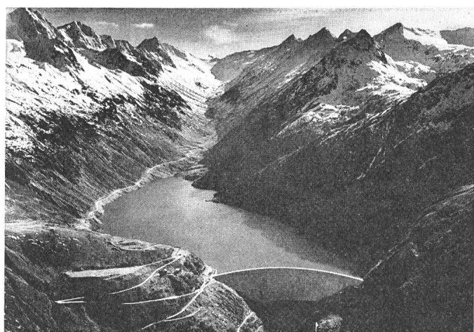
Fig. 3 Staumauer und Stausee Nalps
