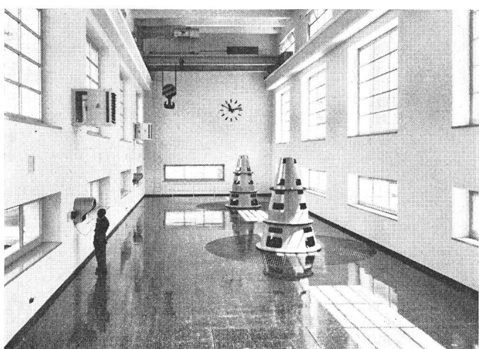
Fig. 3 Maschinensaal in der Zentrale Filisur
