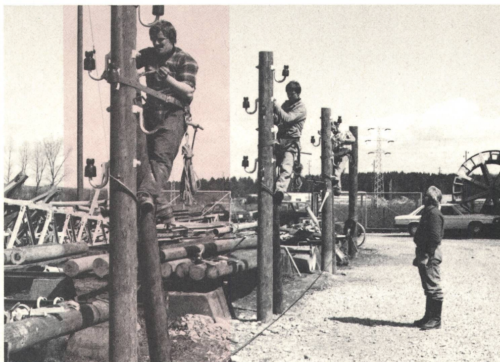
Netzelektriker: ein neu geschaffener Elektroberuf (Im Bild: Praktische Lehrlingsausbildung im Freileitungsbau)
