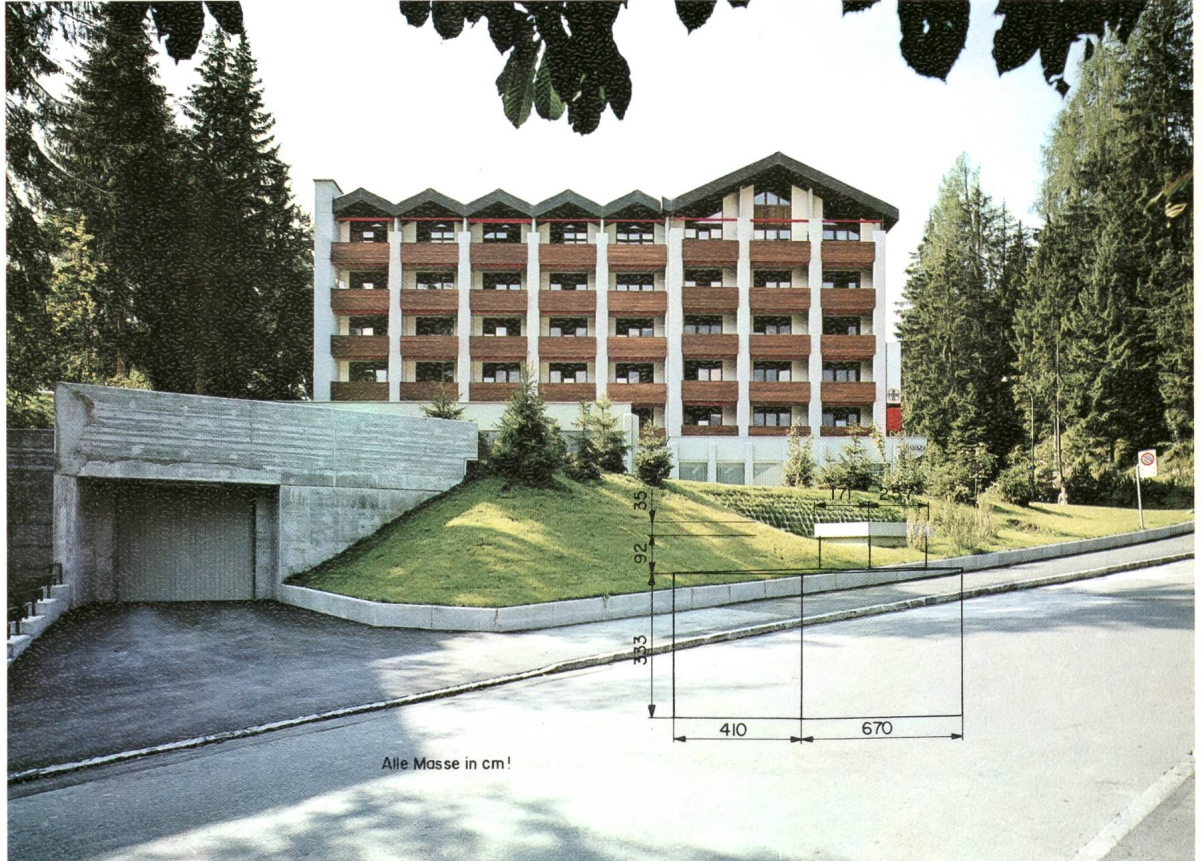
Unterflur-Trafostation EW Flims
