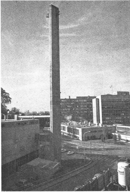
Fig. 7 Centrale thermique de l'Hôpital cantonal de Genève
