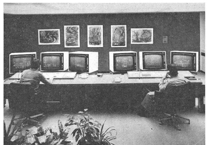
Fig. 2 Raum der Schaltleitung in der Netzwerkzentrale
