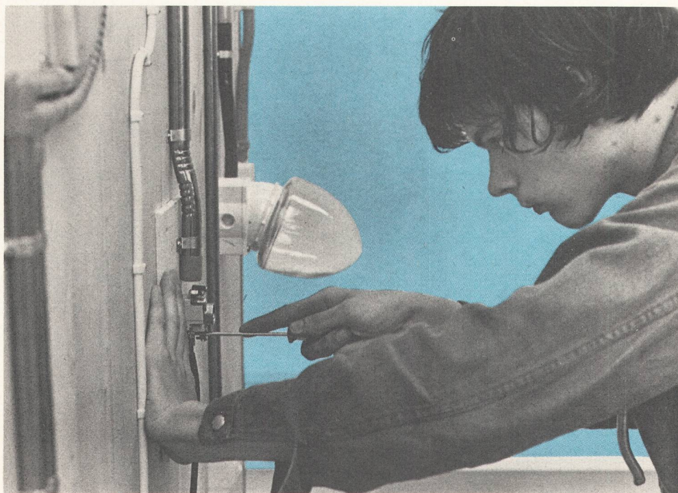
Un apprenti monteur-électricien «à l'œuvre»
