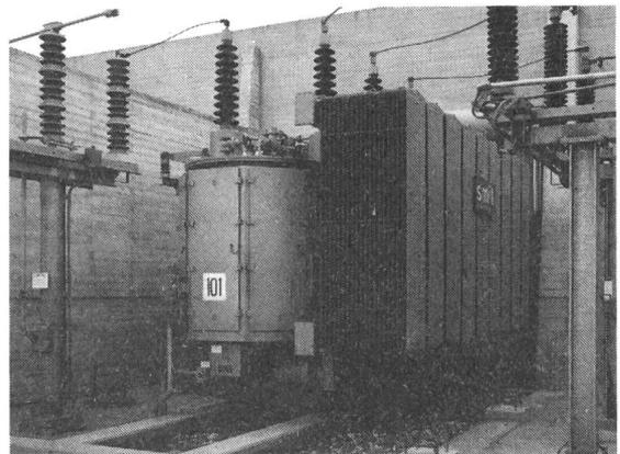
Leistungstransformator für Unterwerk in der BRD, 44 MVA, 150 kV/10 kV, ONAN, regelbar unter Last, Geräuschdämpfung mittels spezieller Verkleidung.
