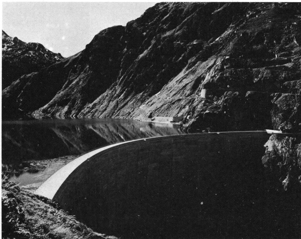
Stausee Curnera der Kraftwerke Vorderrhein AG
