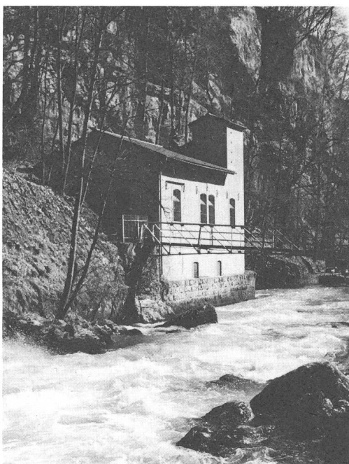
Fig. 1 Eigenerzeugungsanlage in der Taubenlochschlucht
