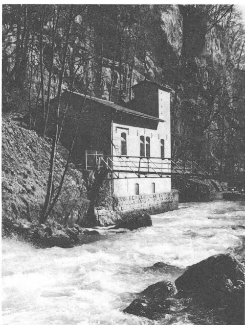
Fig. 1 Eigenerzeugungsanlage in der Taubenlochschlucht
