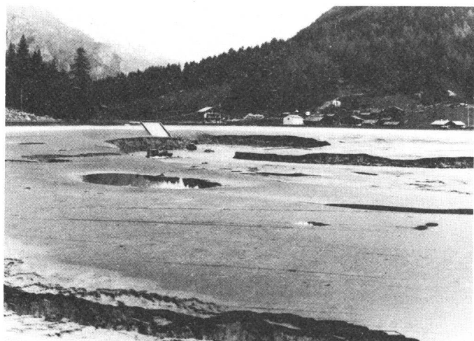
Fig. 1 Ablagerung im Ausgleichsbecken Mattsand
