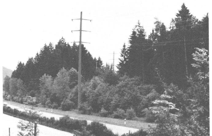
Fig. 15 Halbschneise einer 132/16-kV-Stahlvollwandmastenleitung
