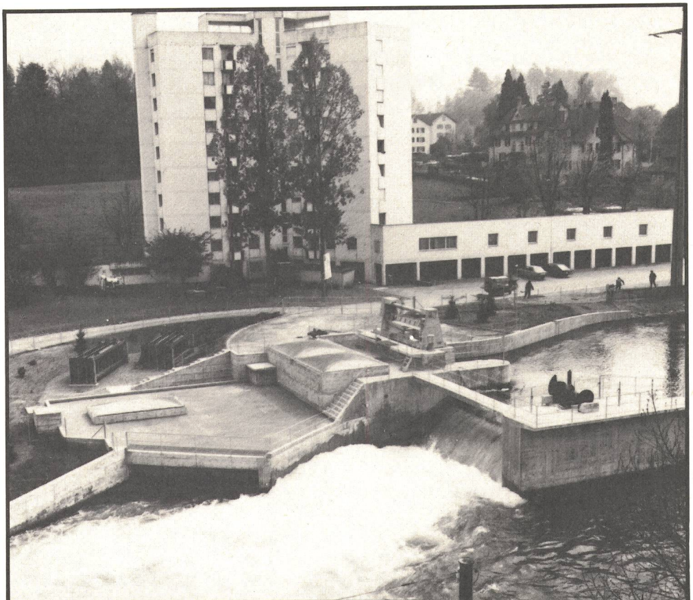
Centrale hydraulique de Perlen après rénovation
