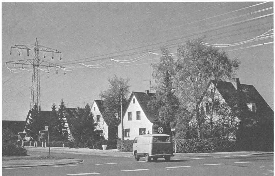
Fig. 1 Rollenleine über Wohngebiet. Im Vordergrund ungespannt, im Hintergrund während Kippvorgang
