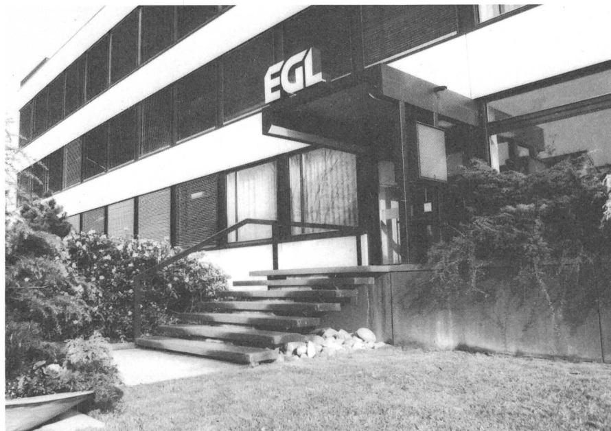
Fig. 1 Betriebsgebäude der Elektrizitäts-Gesellschaft Laufenburg
