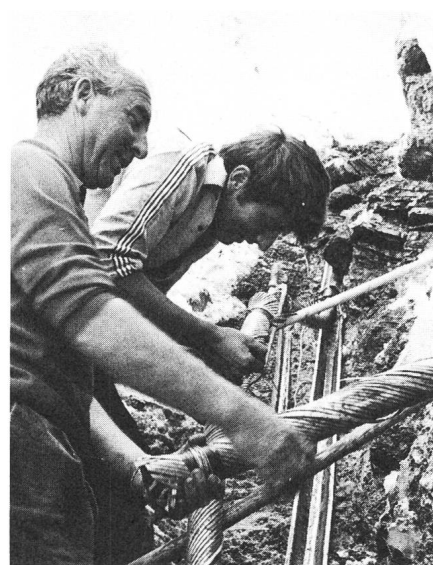
Fig. 3 Jonction de câbles
