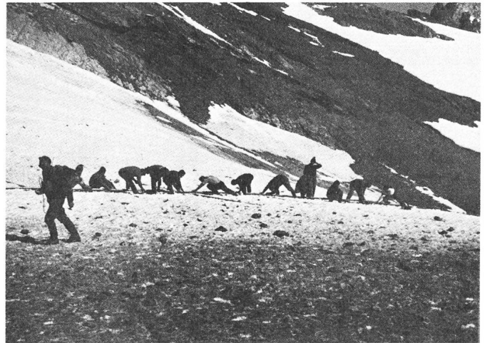
Fig. 6 Hâlage d'un câble sur la Plaine Morte
