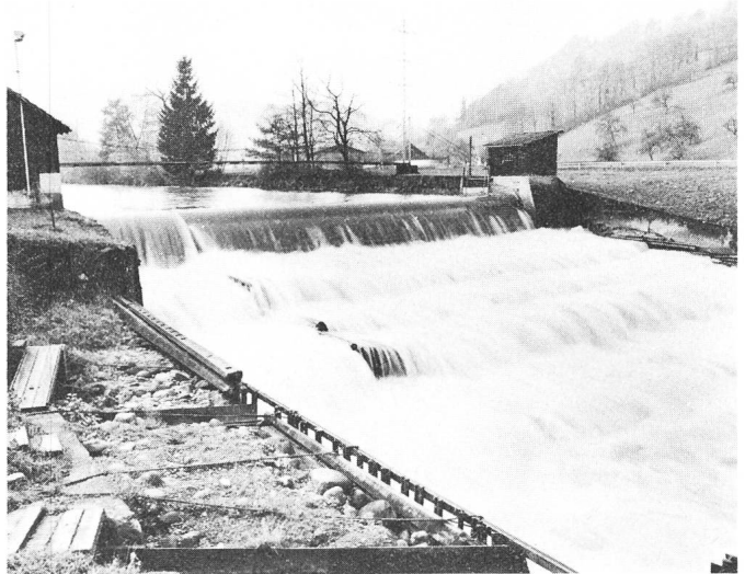
Fig. 2 Stauwehrranlage Ettis- bühl an der Kleinen Emme
