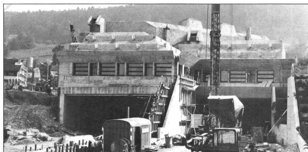
Tunnel-Rohbau Seite Weiningen mit später bepflanzttem Lärmschutzwall
