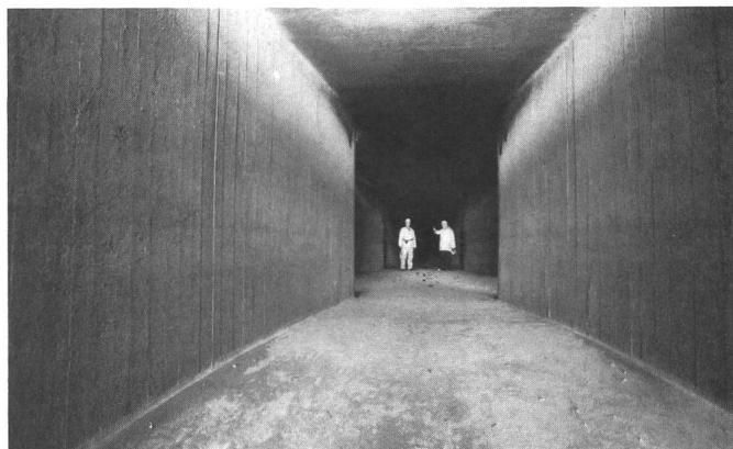
Im Innern des Einlaufbauwerkes zum Druckstollen. Dunkle Öffnung im Hintergrund Beginn des Druckstollens.
