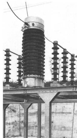
Fig. 7 Moderne (links) und ältere (rechts) kombinierte 170-kV-Strom-Spannungswandler
