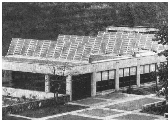
Fig. 2 Die Solarzellen-Anlage TISO-15 an der HTL Lugano, mit 15 kW Leistung die derzeit grösste in der Schweiz, ist ebenfalls NEFF-gefördert
