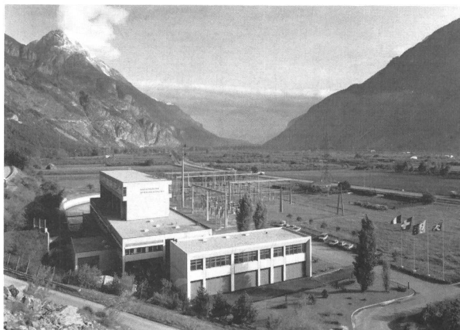
Fig. 1 Centrale de La Bâtiâz A l'avant-plan: bâtiment administratif chauffé par récupération de l'énergie de refroidissement des transformateurs 220 kV/90 MVA
